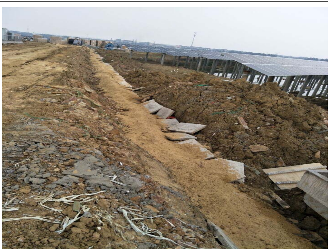
集电线路直埋铺沙盖板
