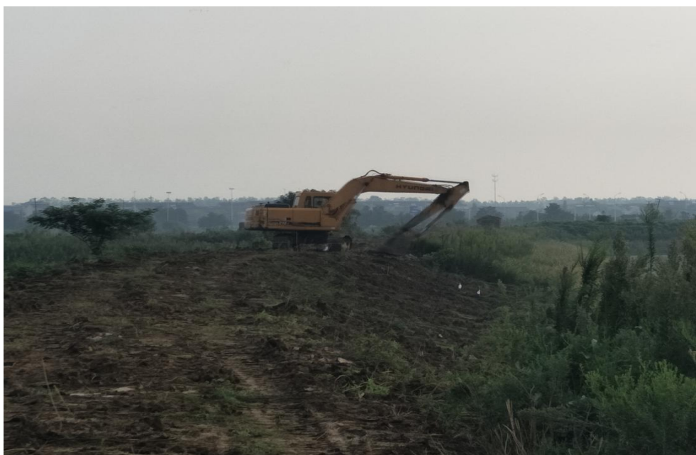
工地巡视三区修施工路 20170811
