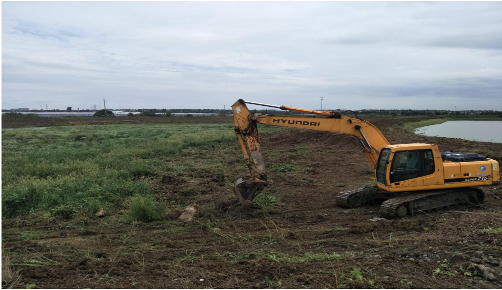
工地巡视三区修施工路 20170813
