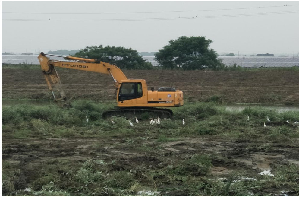
工地巡视三区平整鱼埂 20170814
