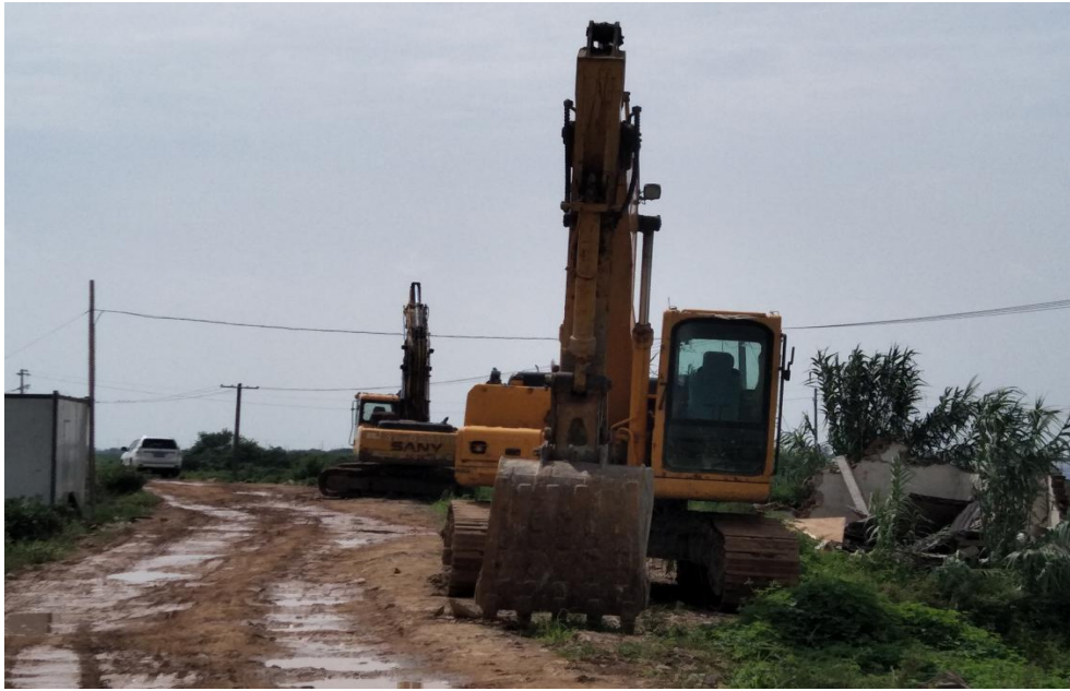
工地巡视六区中雨停工 20170816
