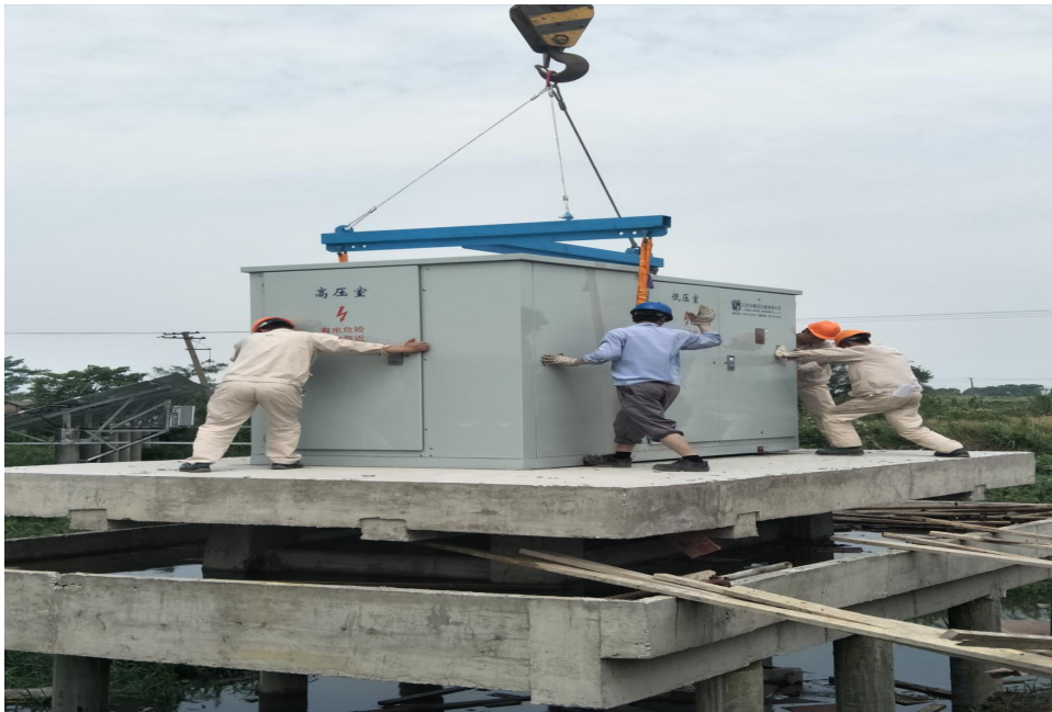
增补区箱变吊装
