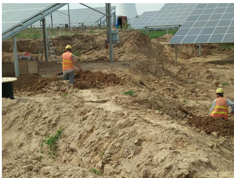
光伏电缆敷设
