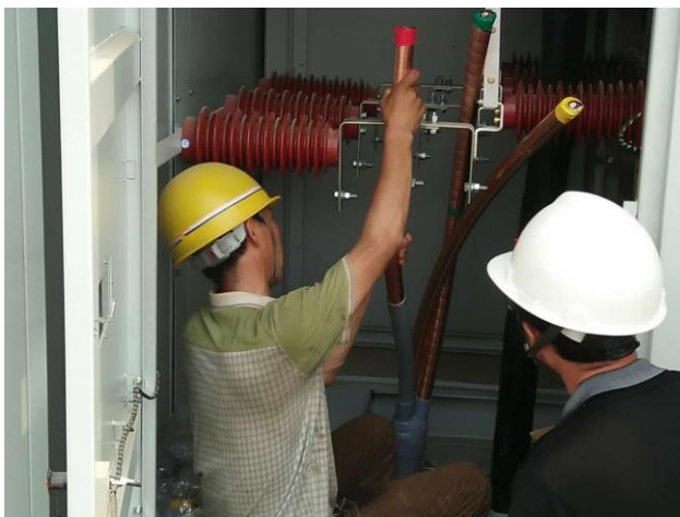
高压电缆头制作旁站
