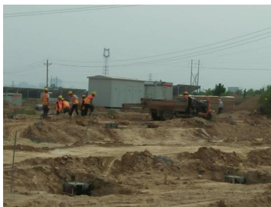
大棚基础浇筑
