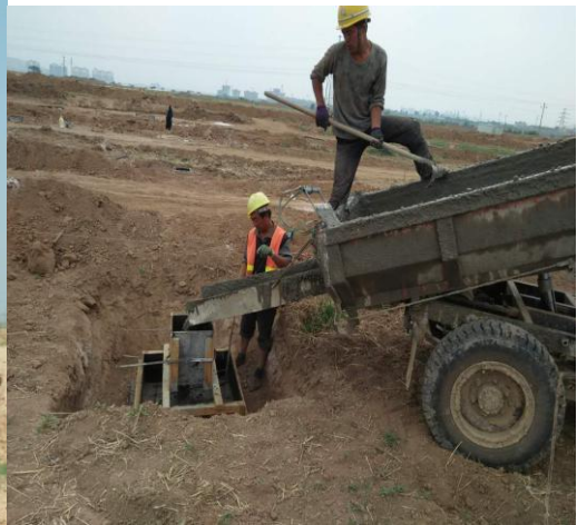
大棚基础浇筑
