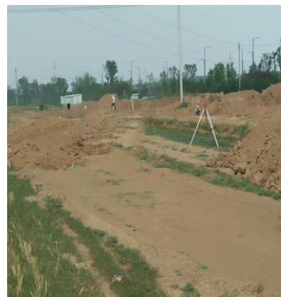
大棚基础开挖
