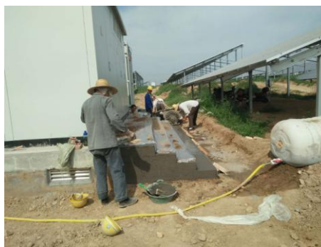
箱逆变台阶施工
