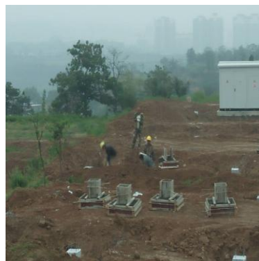
混凝土浇筑
