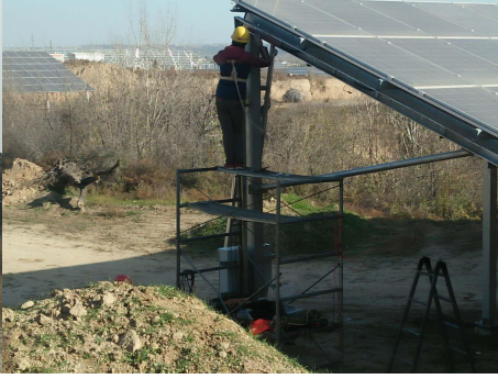
光伏电缆敷设
