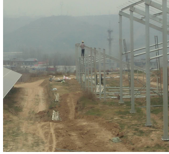
电缆桥架施工
