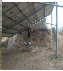
光伏电缆穿线
