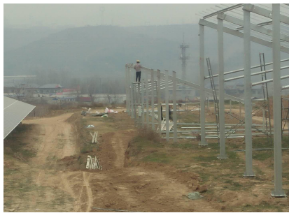
支架组件安装
