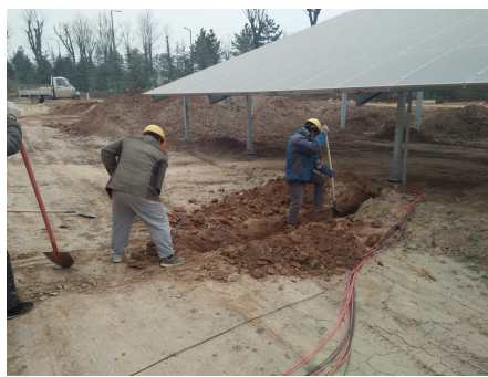
1 电缆沟人工开挖
