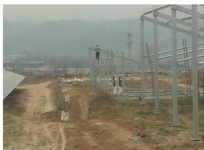
支架组件安装
