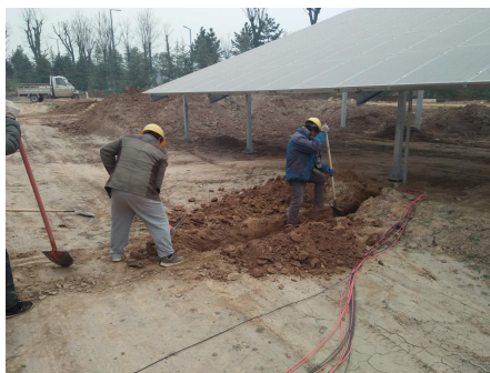
1 电缆沟人工开挖
