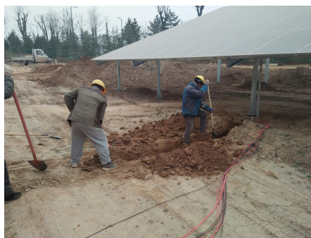
1 电缆沟人工开挖
