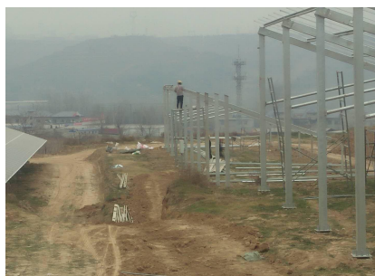
支架组件安装
