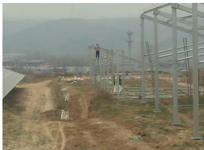
支架组件安装
