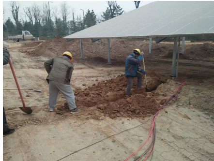
1 电缆沟人工开挖
