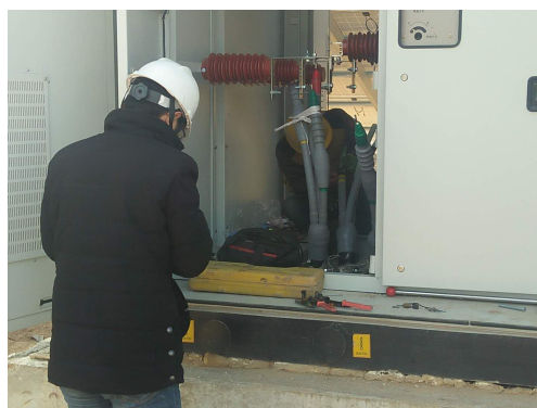
高压电缆头制作监理旁站
