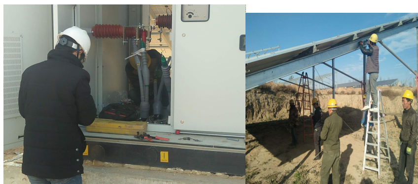
高压电缆头制作监理旁站
