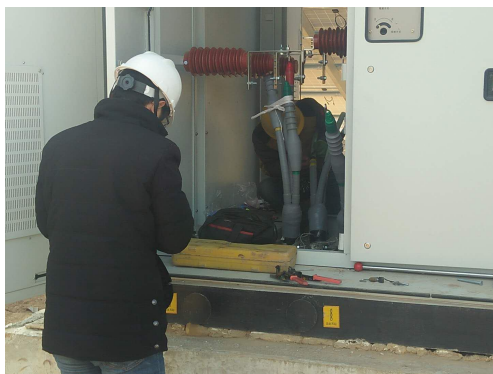
高压电缆头制作监理旁站
