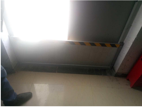
35KV 挡鼠板制作
