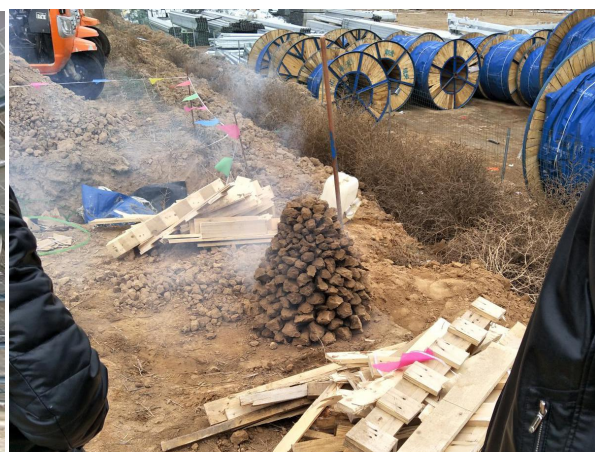
施工人员生火
