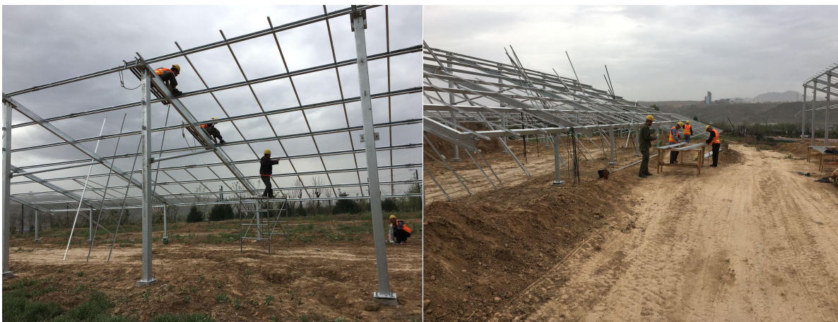
光伏区 2、8 单元支架安装
