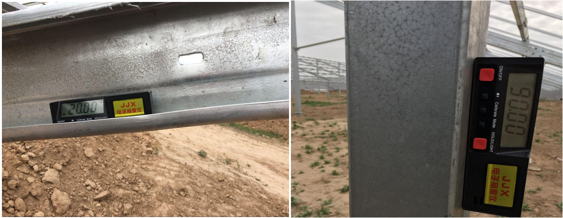
大棚支架立柱、斜梁角度测试
