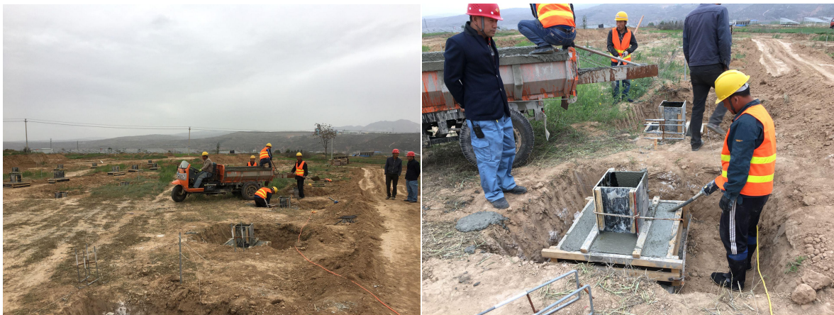
12 单元大棚基础浇筑
