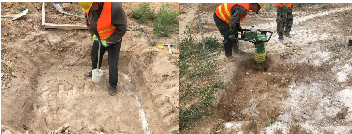
大棚基础基础夯实
