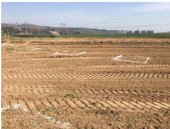
路南定位放线
