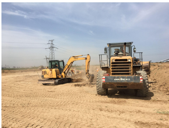
21 单元基坑开挖
