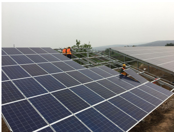
2 单元组件安装
