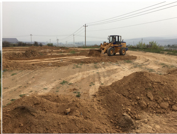
13 单元大棚基础回填
