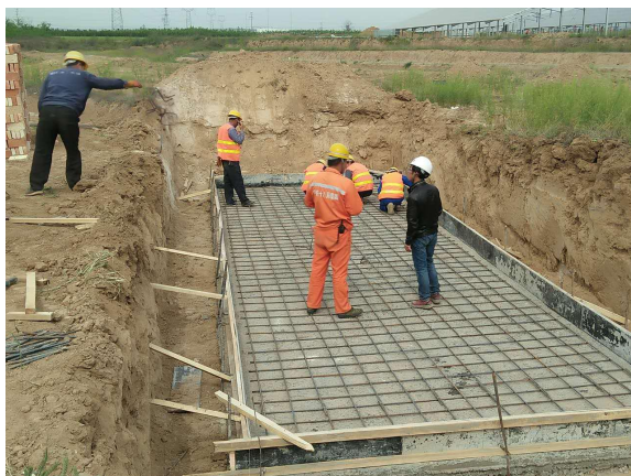
箱逆变基础绑扎
