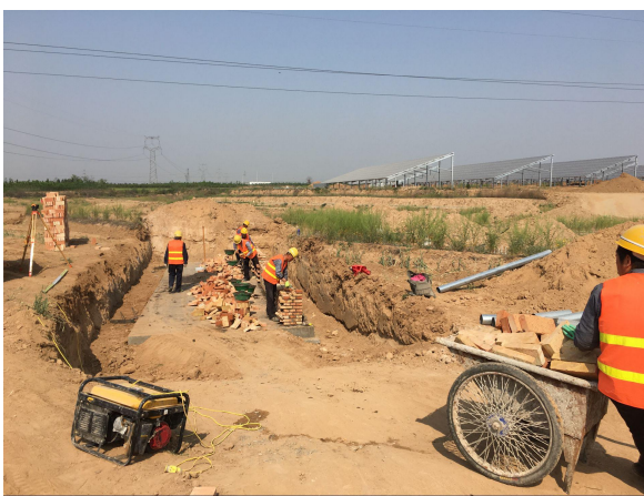
箱逆变基础砌筑
