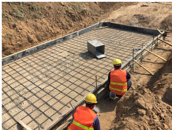
箱逆变钢筋绑扎、支模
