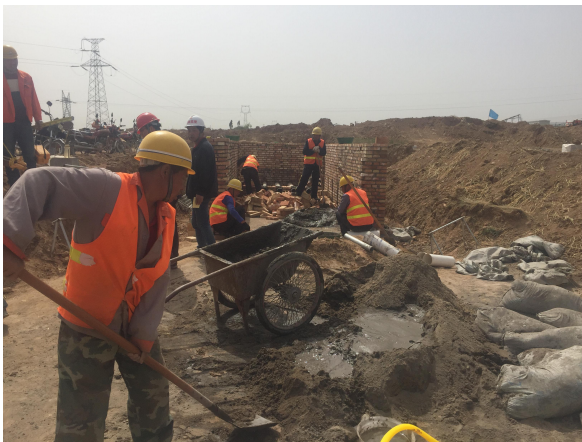
箱变基础砌筑
