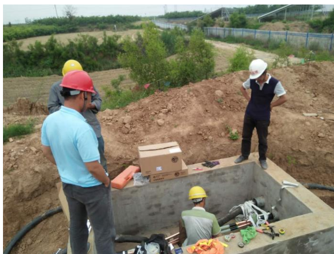
带电前检查旁站
