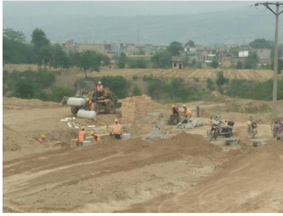
箱逆变基础砌筑
