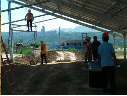
电缆桥架安装箱逆
