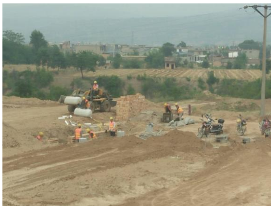
箱逆变基础砌筑
