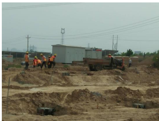
大棚基础浇筑
