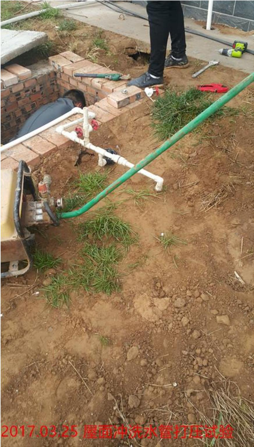
2017.03.25 屋面冲洗水管打压试验
