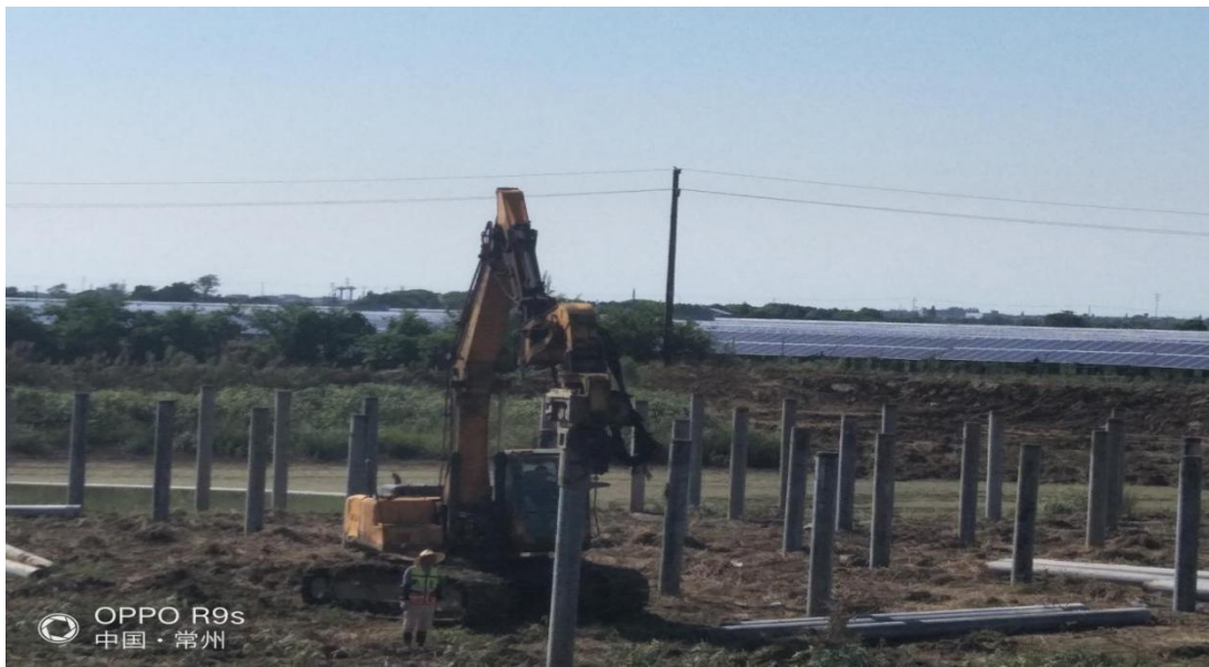
工地巡视二期主干道修整、六区打桩 20170823
