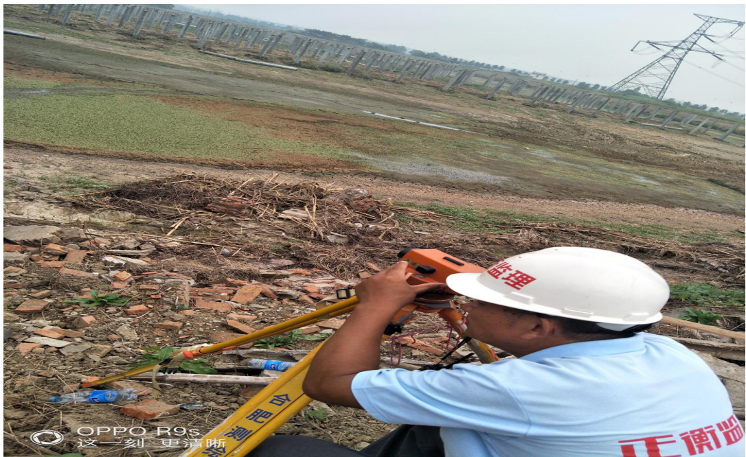
六区 26#、28#引孔、七区打测试桩 20170917
