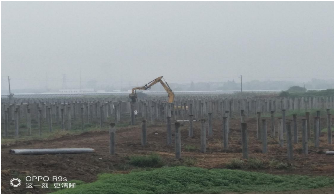
工地巡视六区 26#、28#引孔、打桩 20170920 上午、下午阵雨停
