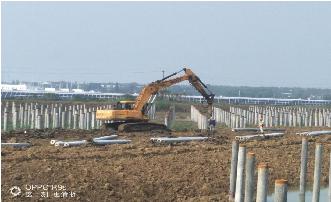
工地巡视 26#子阵引孔、28#子阵打桩 20170926
