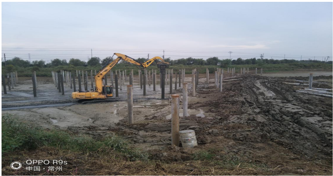
工地巡视七区 29#子阵挖机拖桩、31#子阵挖排水沟 20171014
