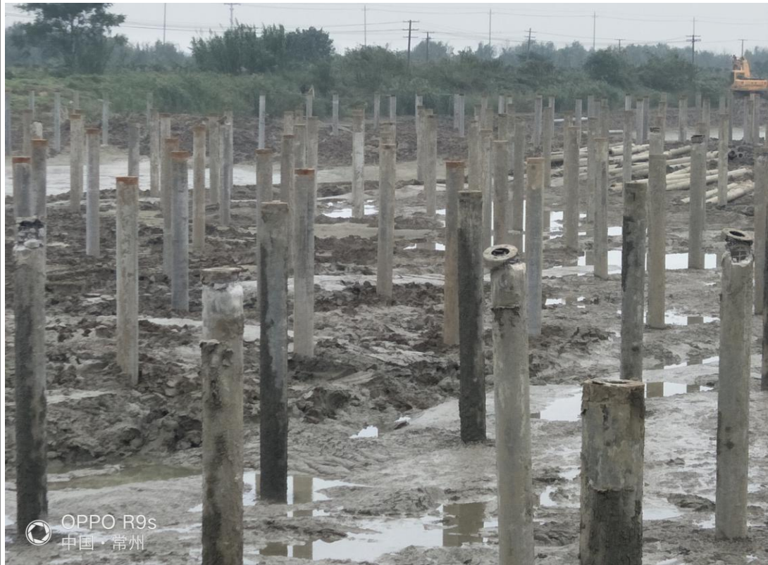
工地巡视 29#子阵打爆桩头 20171019
