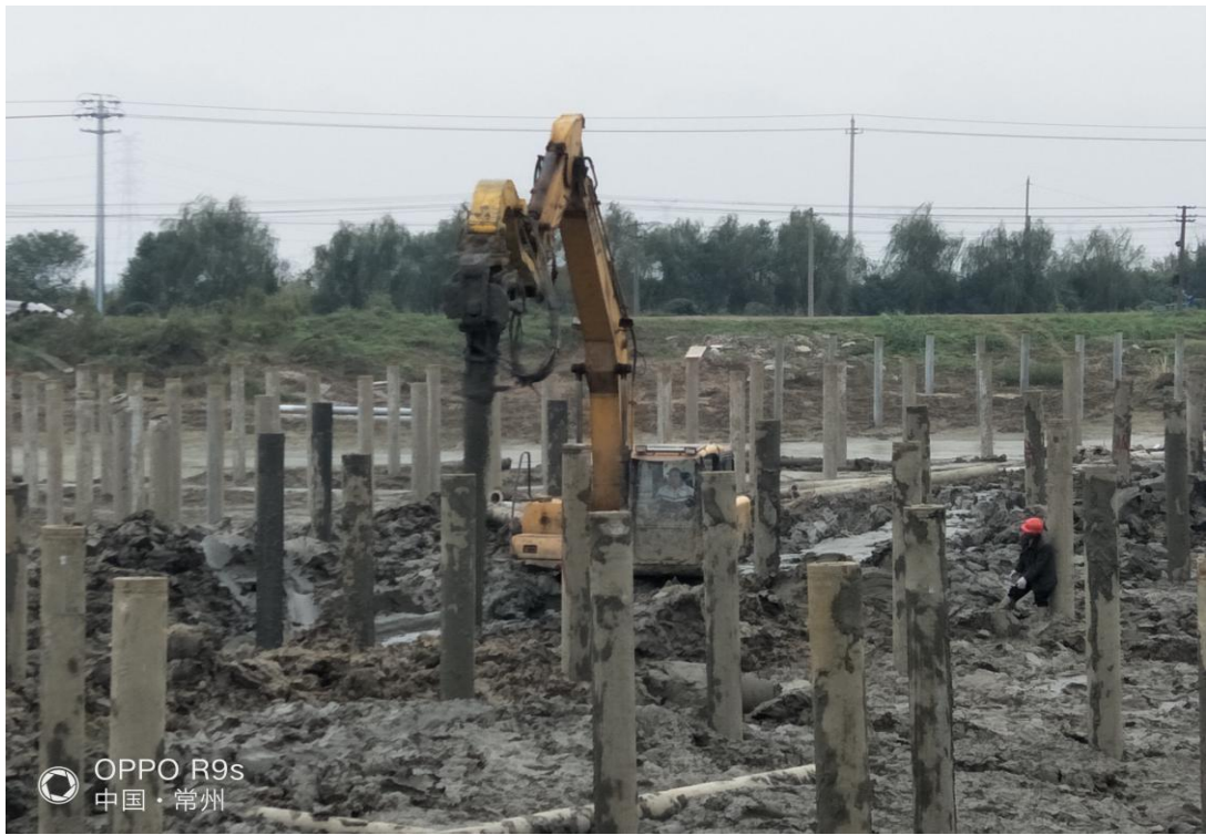
工地巡视 29#子阵打桩 20171019
