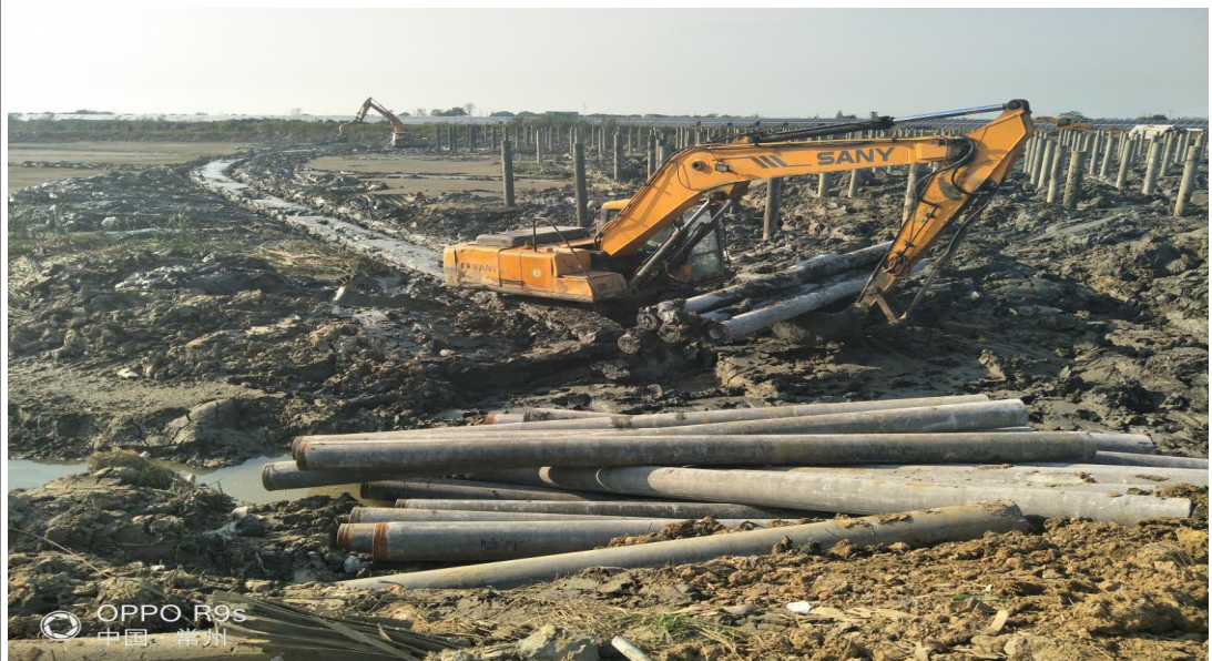
工地巡视七区 30#子阵拖桩、打桩 20171025
