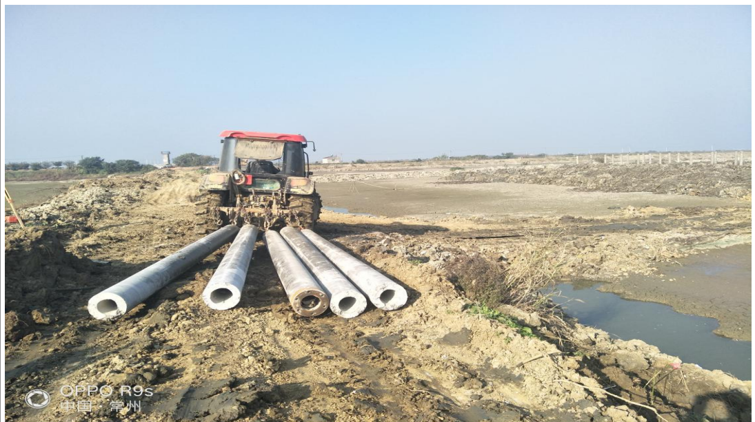
工地巡视 32、34#子阵拖桩、打桩、检测桩标高 20171106
