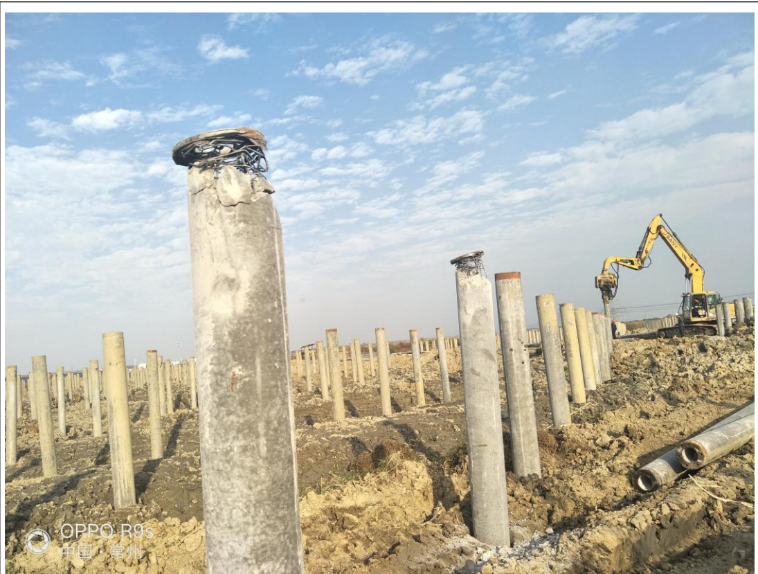
工地巡视 30#子阵补桩打爆桩帽 20171108
