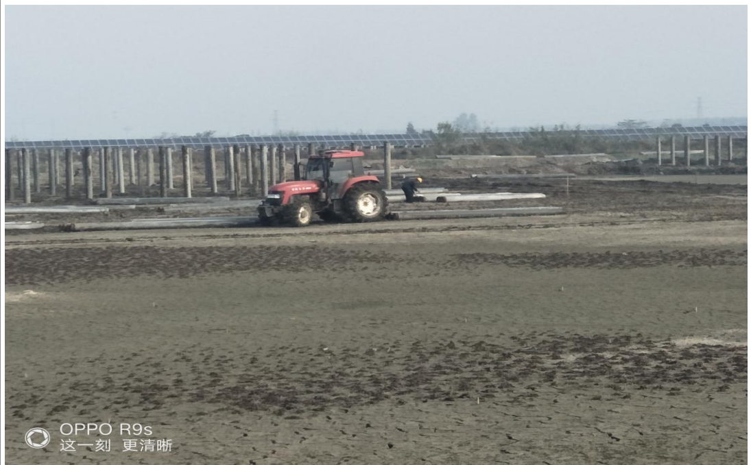
工地巡视七区打桩拖桩 20171110
