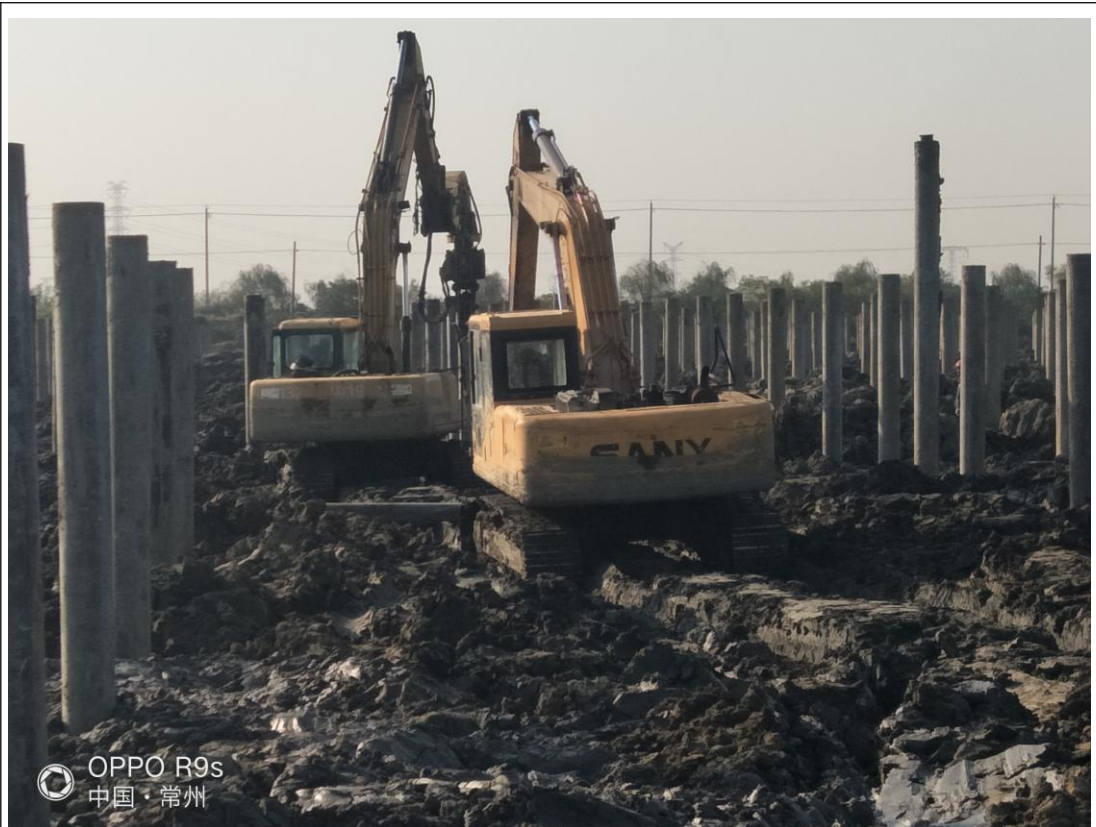
工地巡视七区 32/34/35#子阵打桩拖桩 20171111
