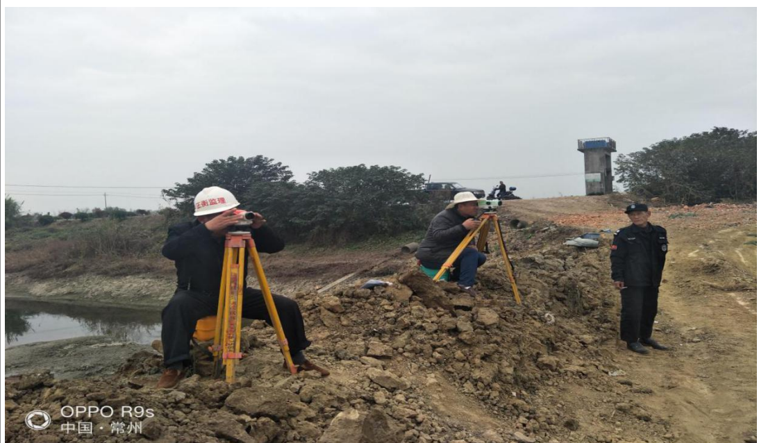
工地巡视六区修施工路、拖增补桩、七区检测桩标高、35#子阵打桩 20171113
