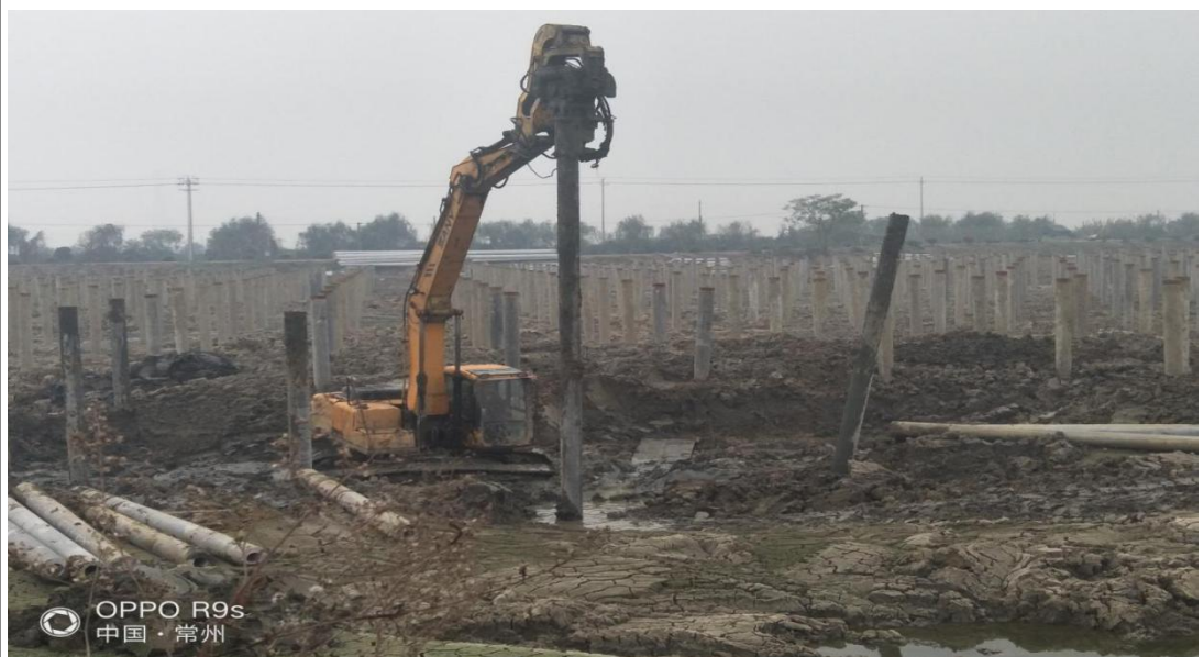
工地巡视 32、33#拖打增补桩、31#子阵深塘打 8 米桩、35#子阵打桩 20171114
