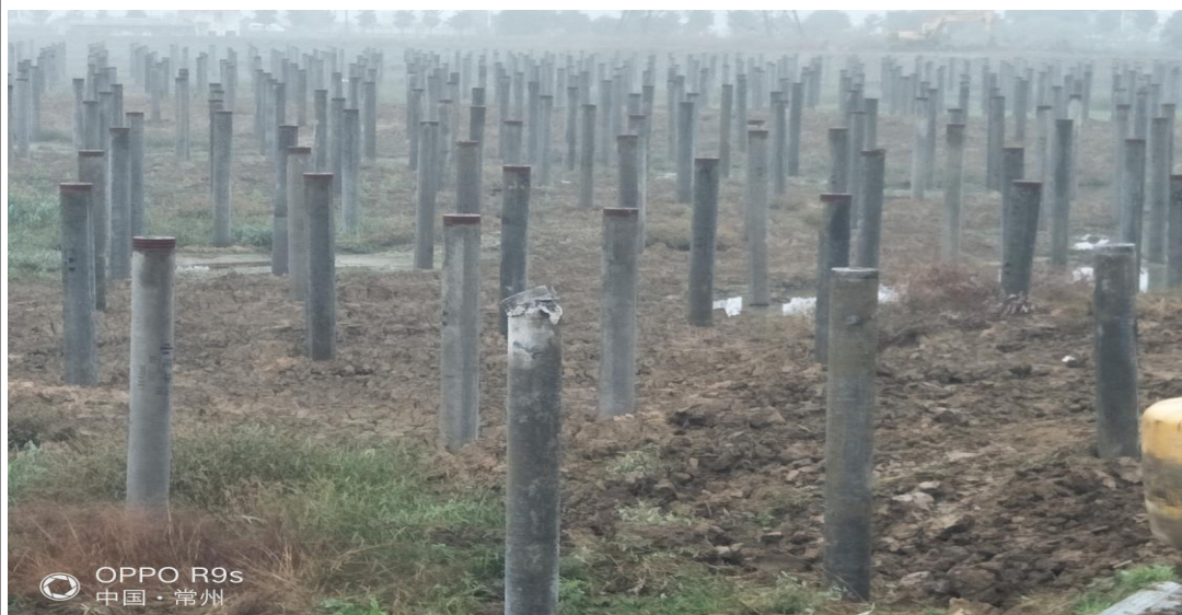
六区增补区打桩、打爆桩帽、七区 34、35#子阵打桩 20171117
