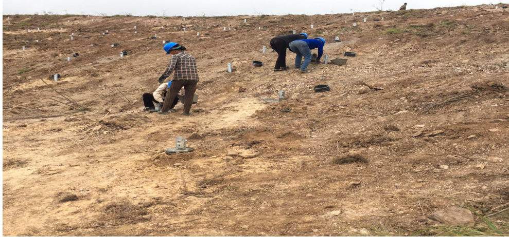
因下雨很多施工场地停工 工地巡视 20170826
